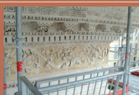
↑ Essais d'eau forte d'harmonisation frise Testing limewash on a frieze
