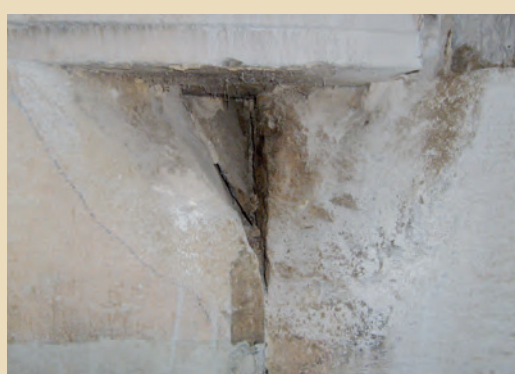
↑ État de la pierre avant intervention State of the stone before the work
