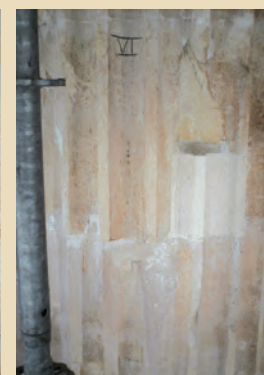
↑ Collage des éléments et réalisation d'une greffe Binding the components and performing the graft
