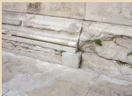
↑ Remplacement d'un élément de socle de stylobate Replacement of a stylobate base element
