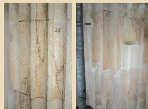
↑ État de la colonne avant intervention State of the column before the work
